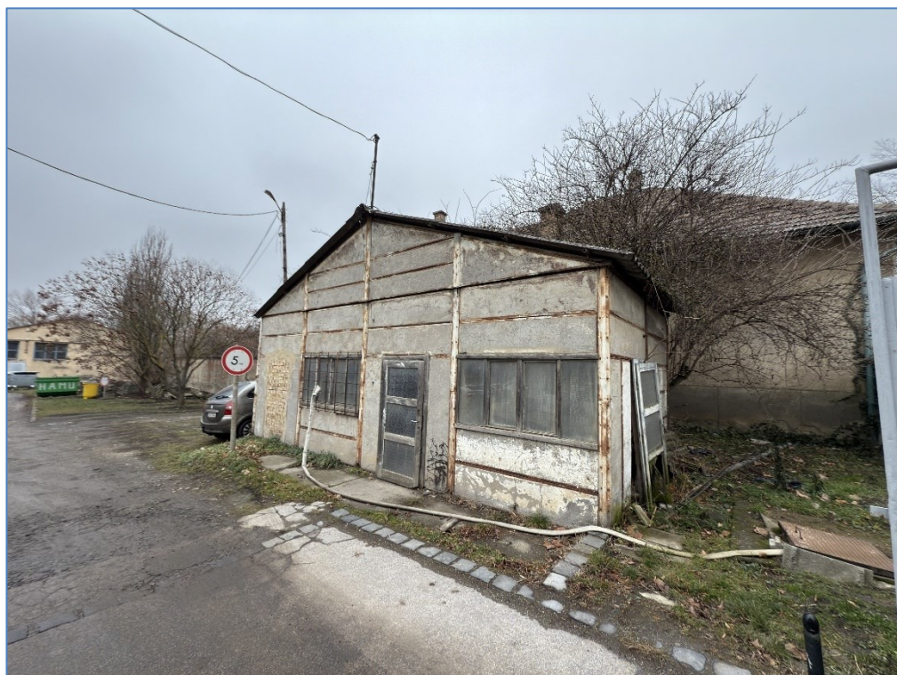
Első lebontandó épület.
